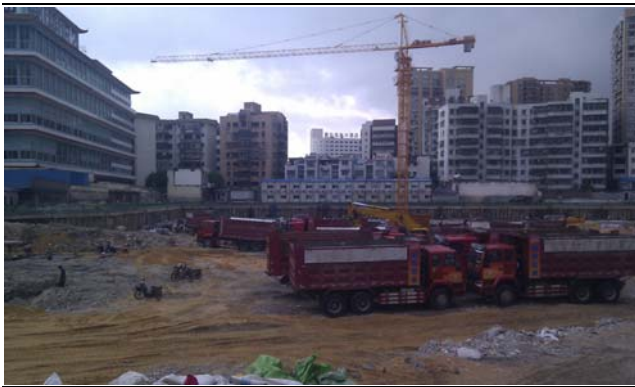
图表 5.海口市区椰岛广场项目现场
