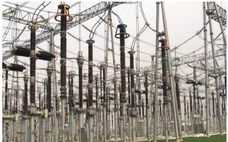
图 3: 电站用棒形支柱瓷绝缘子
