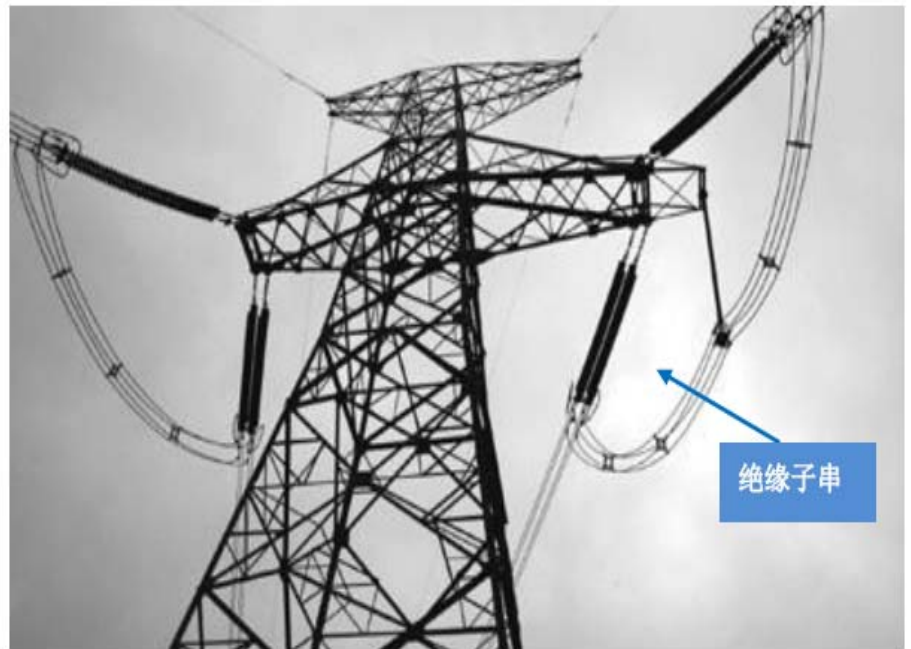
图 2: 输电线路用瓷绝缘子
