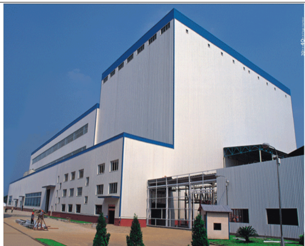
图 19：轻钢结构-衡阳特变电工衡阳变压器厂
