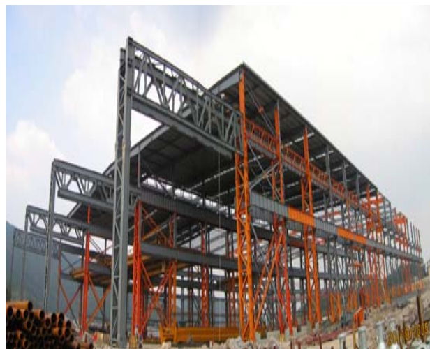
图 20：轻钢结构-浙江造船厂
