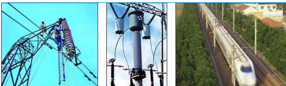
图表34：绝缘子应用实例（线路盘式、电站支柱和高铁用绝缘子）
