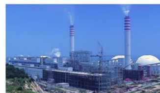
漳州后石电厂(脱硫等设备钢结构)
