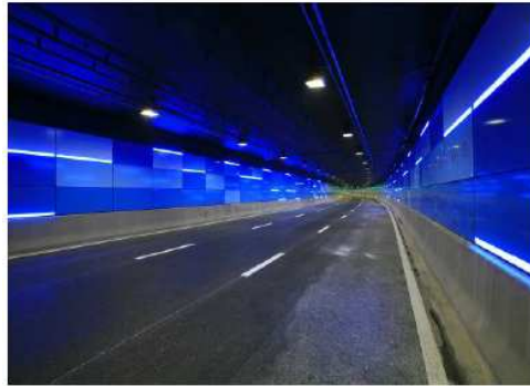
上海外滩隧道
