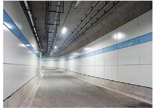
北京奥林匹克公园地下联系通道
