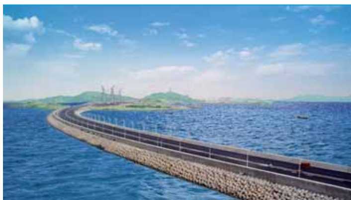
图表3：海堤工程建设展示图——东海大桥海堤
