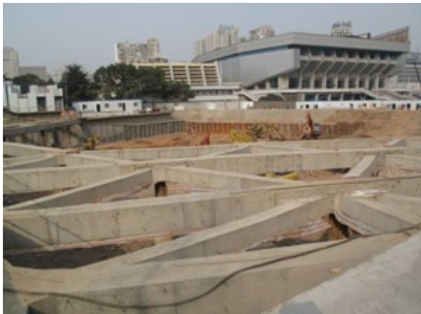
图 6： 洪广首座/悦公馆项目实景
