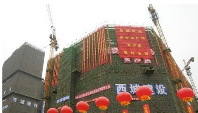
图 3：河西店目前的施工进度图
