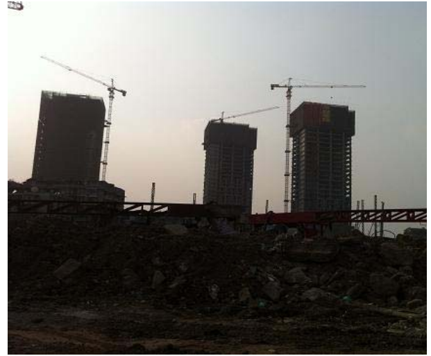
图 2: 水岸星城工地现场
