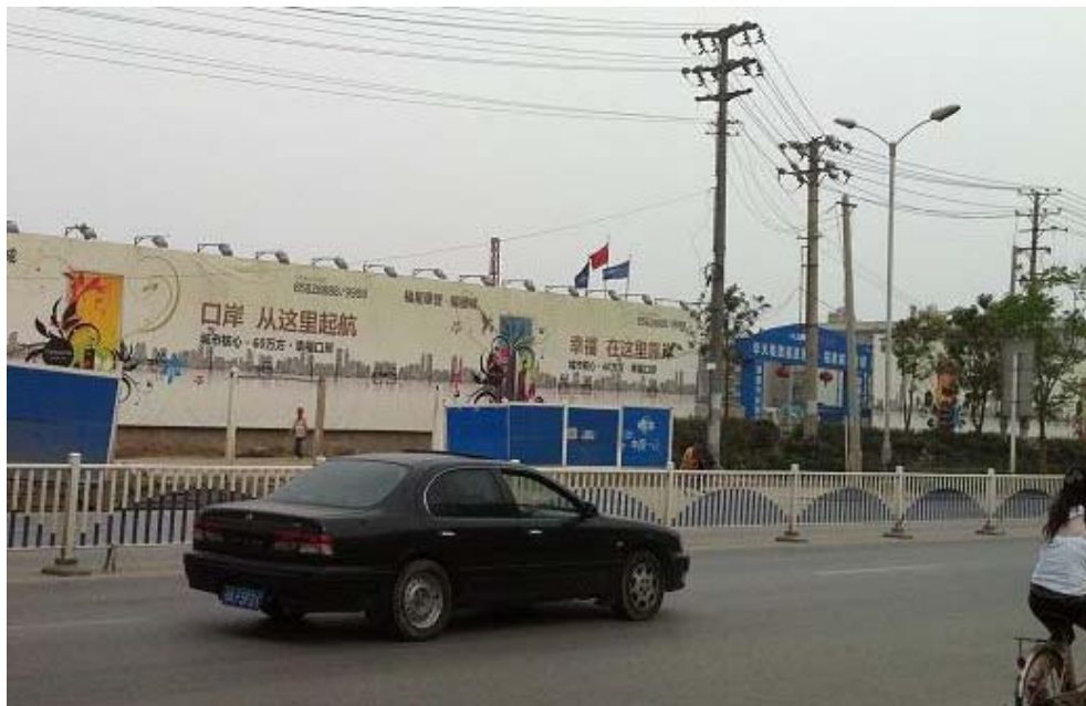
图 8： 福星城项目现场图
