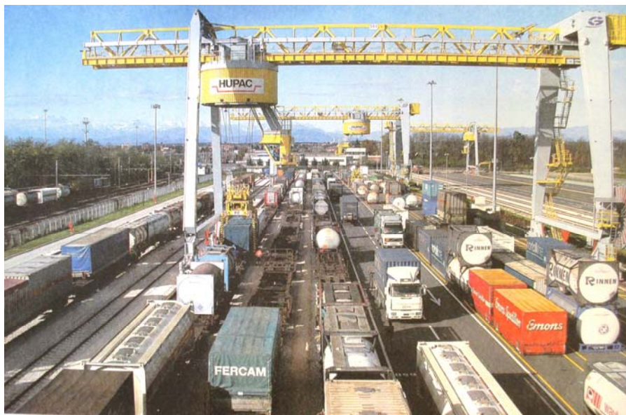
图27：集装箱班列在中心站等待装卸
