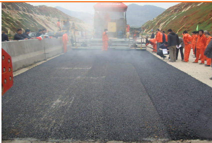
图 12: 宜连高速沥青混凝土下面层试铺成功
