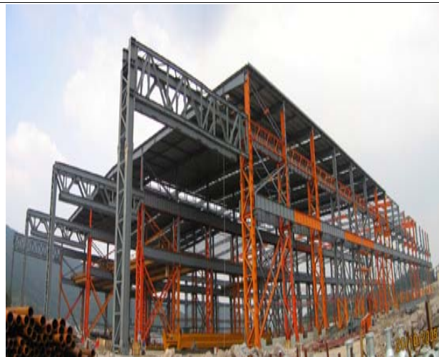
图 22：轻钢结构-浙江造船厂
