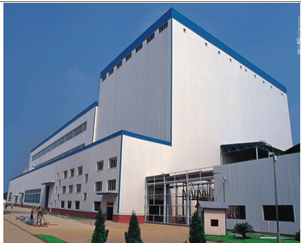
图 21：轻钢结构-衡阳特变电工衡阳变压器厂
