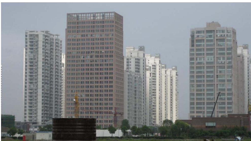
图表 32：南通中南世纪城(CBD)项目实景图
