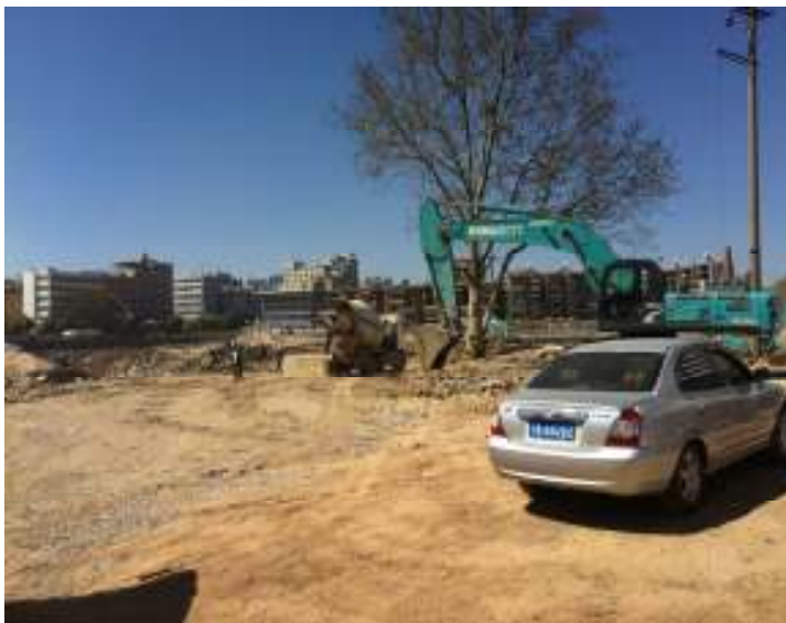
图 3：关上中央商务区工地 1
