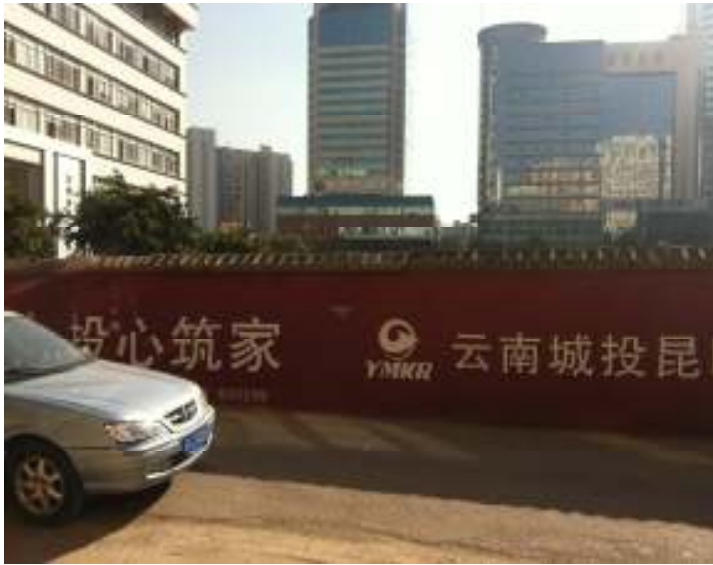
图 1：吹箫巷项目工地 1
