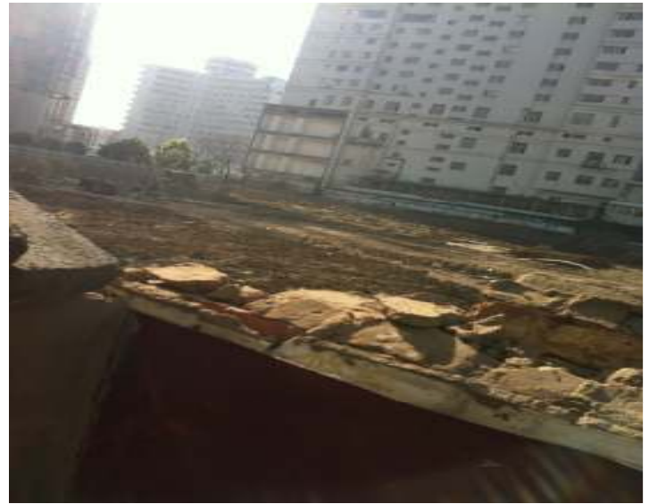
图 2：吹箫巷项目工地 2
