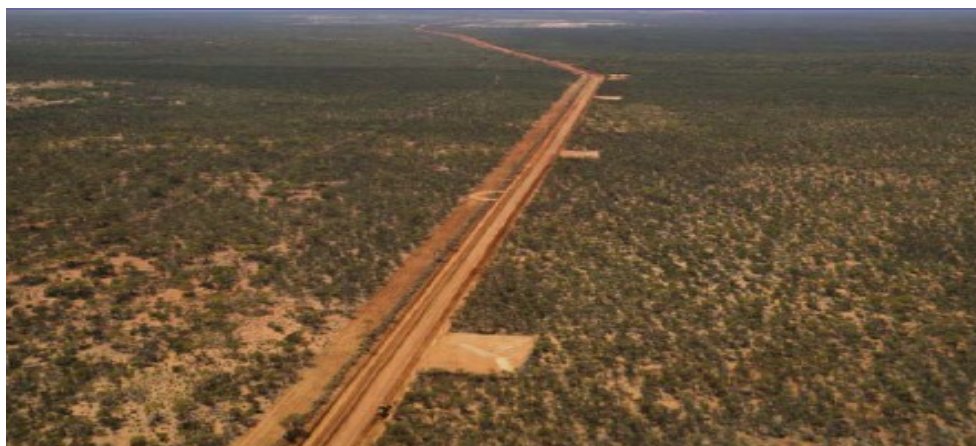
图 11: 卡拉拉项目基础设施情况
