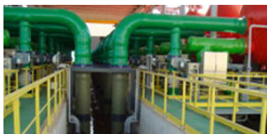
图表 11：海水淡化玻璃钢管（左图）；各管材的单位长度重量（kg/m）（右图）
