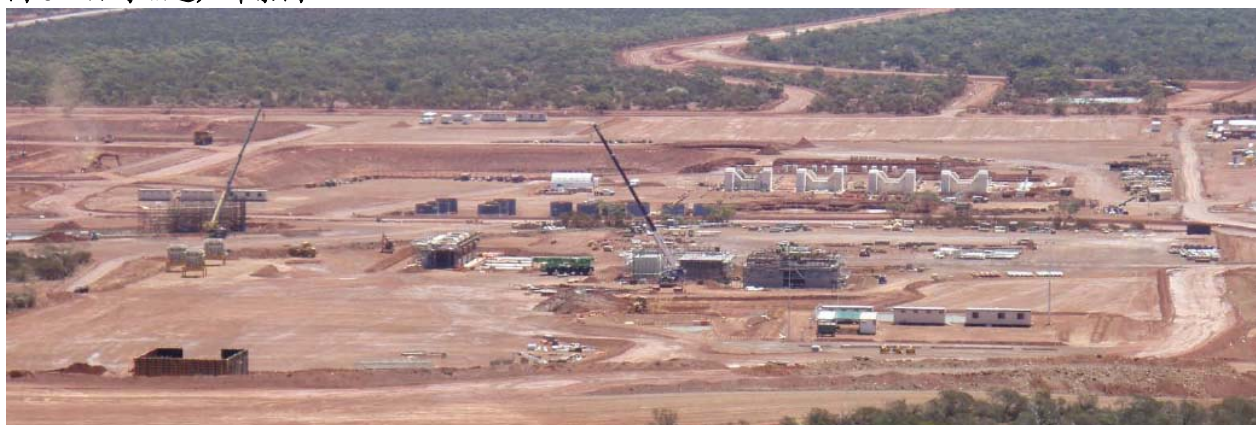
图 4 330KV 变电站一已安装完毕
