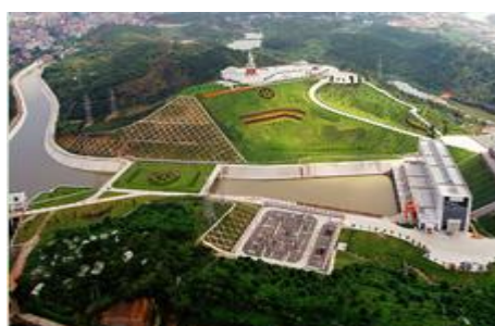
图 12： 公司承建的东深供水改造工程---金湖泵站
