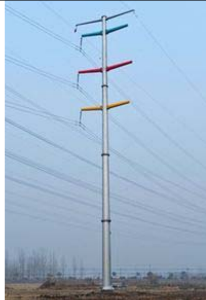
d、220KV 复合材料绝缘杆塔
