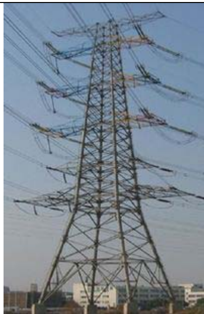
c、1000KV 晋东南变电构支架
