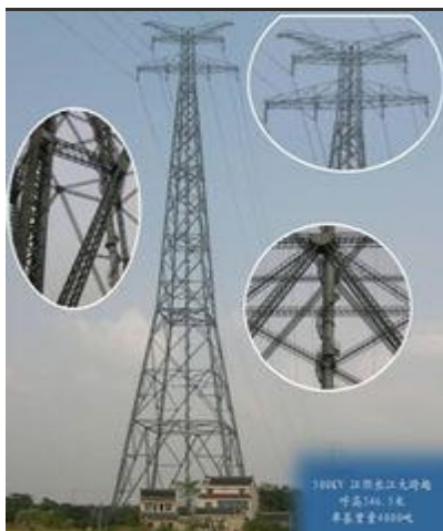
图 2 500KV 江阴长江大跨越角钢塔
