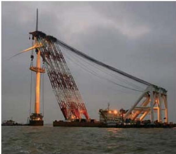
图 2 公司 3MW 海上风电机组吊装
