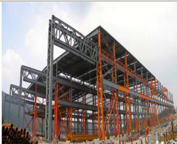
图 6：轻钢结构-浙江造船厂
