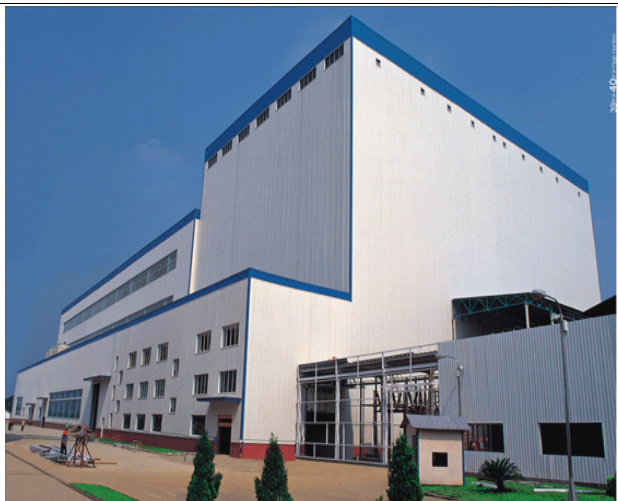
图 5：轻钢结构-衡阳特变电工衡阳变压器厂
