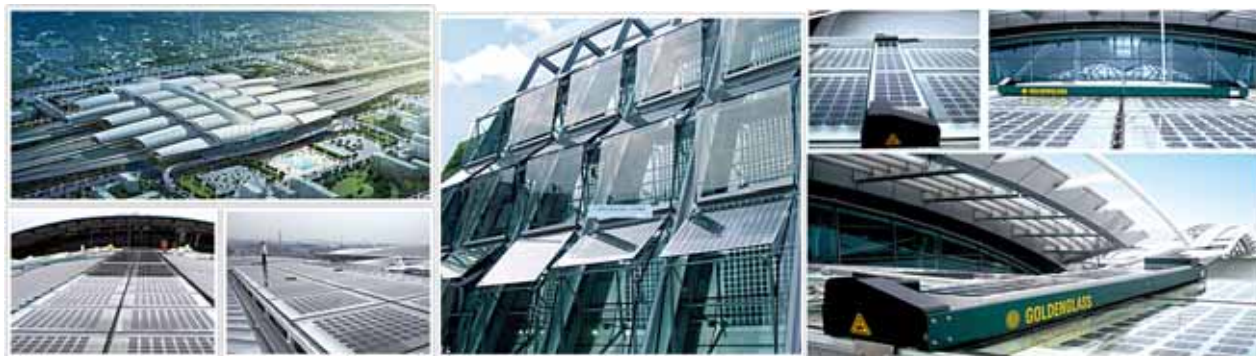
图 5 广州新客站 BIPV 系统、上海世博法国阿尔萨斯案例馆 BIPV 应用、BIPV 屋顶清洗机器人
