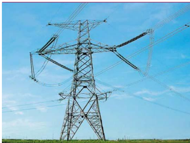
图 1：作为架空地线（最上方的 2 根避雷线）
