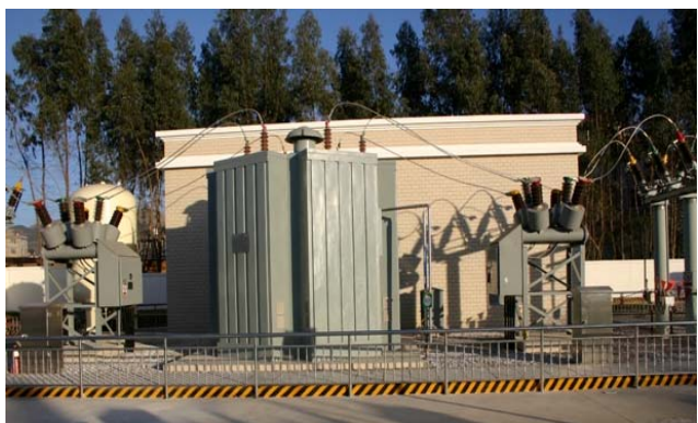
图表 12：380V 三相超导限流器样机（左）正式挂网运行的 35kV/90MVA 超导限流器（右）
