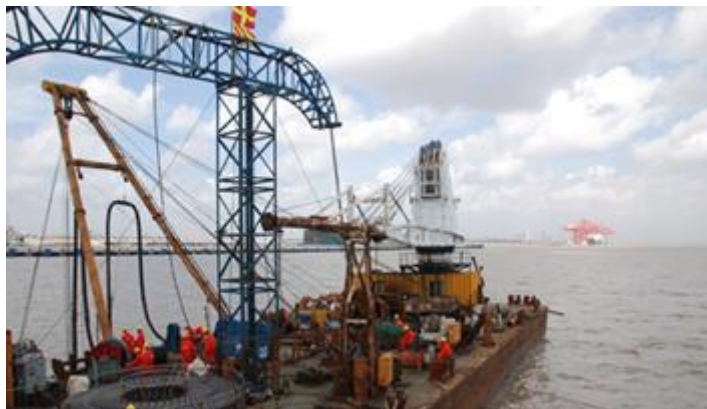
图 30 中天海缆施工
