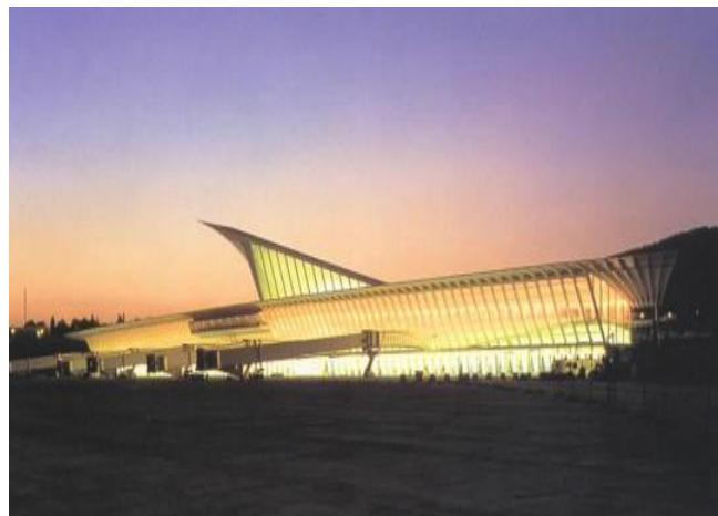
北京植物园展览温室三面网架结构
