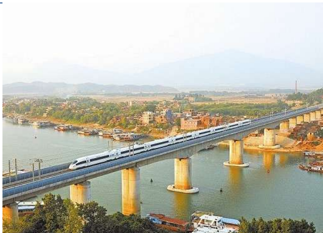
图 4: 列车行驶在武广高速铁路清远北江特大桥上
