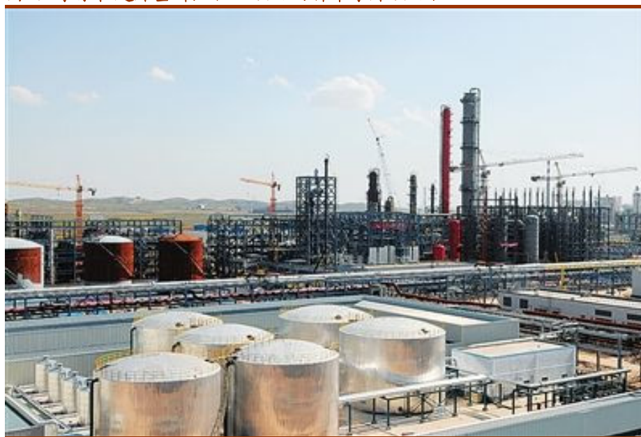
图 1：宁东在建煤基烯烃化工项目（神华宁煤项目）
