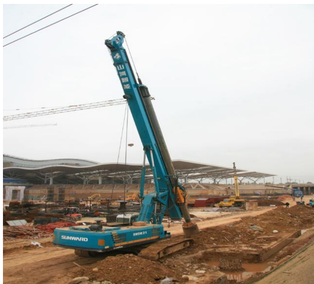
图 21、公司旋挖钻机产品在武广客运专线长沙站引桥工程中应用
