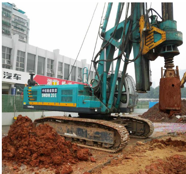
图 22、公司旋挖钻机产品在长沙地铁二号线锦泰广场站中应用
