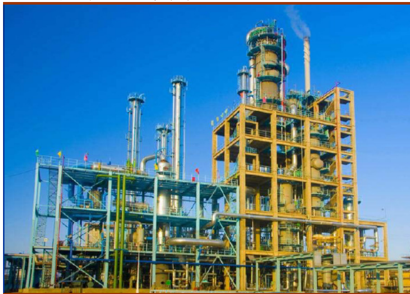
图 22: 淮化集团3万吨甲醇/年FMTP工业试验装置
