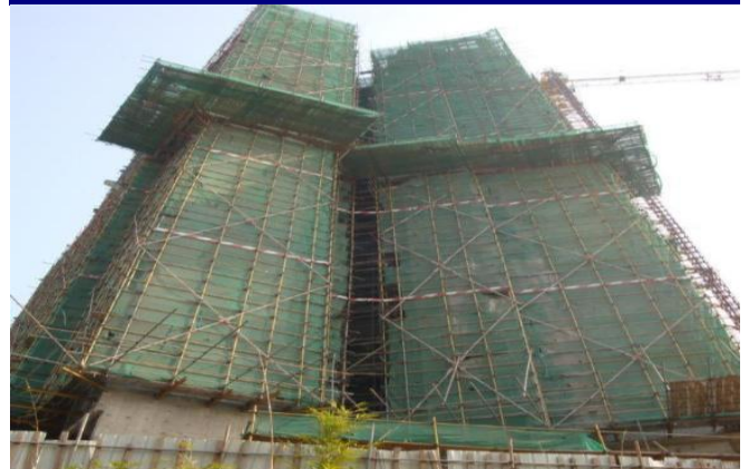
图 7：二期工程进度情况（2009 年 12 月）
