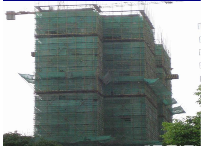
图 9：二期工程进度情况（2009 年 9 月底）
