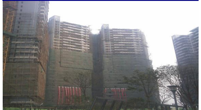
图 5：二期工程进度情况（2009 年 11 月）
