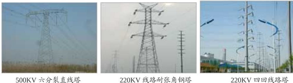
500KV 六分裂直线塔
