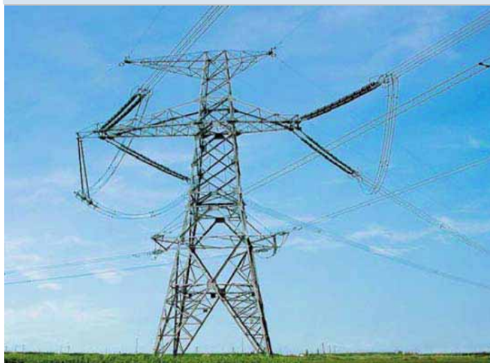
图表2：作为架空地线（最上方的2根避雷线）
