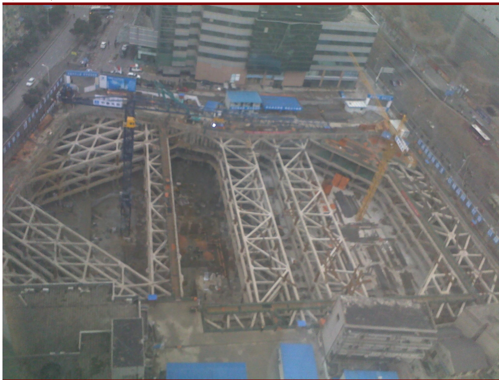
图 1：新金陵项目施工现场
