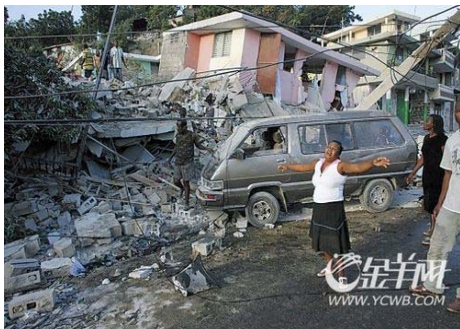
海地地震 7.0 级大面积房屋倒塌
