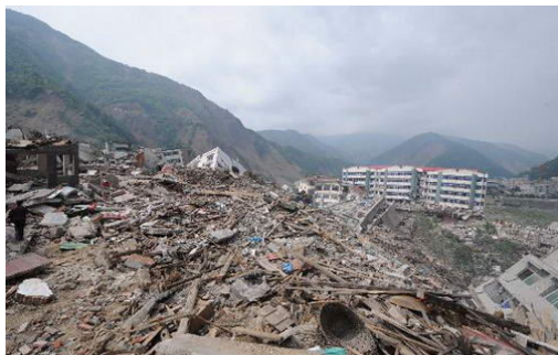
图 2：汶川地震 7.8 级导致房屋大面积损毁
