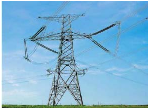
图 1：公司产品作为架空地线（最上方的 2 根避雷线）
