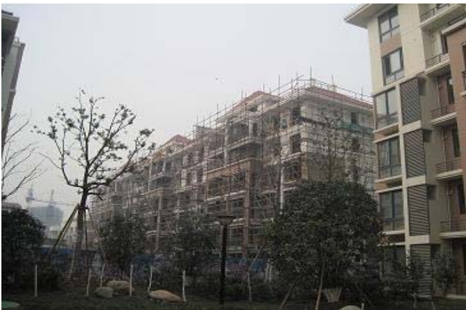
图 7: 合肥琥珀名城沁园项目多层准现房实景
