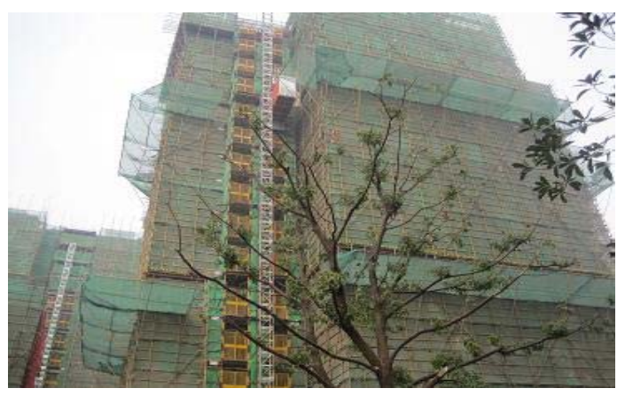
图 8: 合肥琥珀名城沁园项目高层准现房实景
