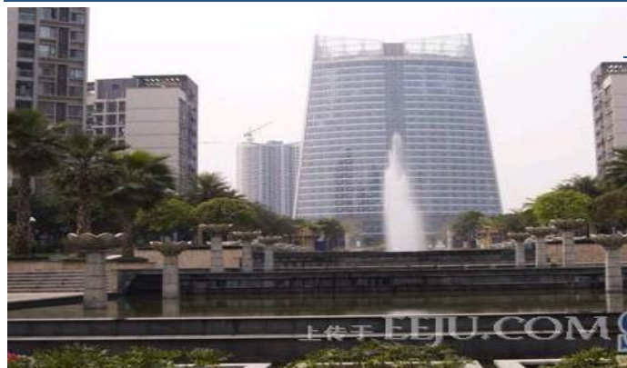
图 39：廊桥水岸外景图
