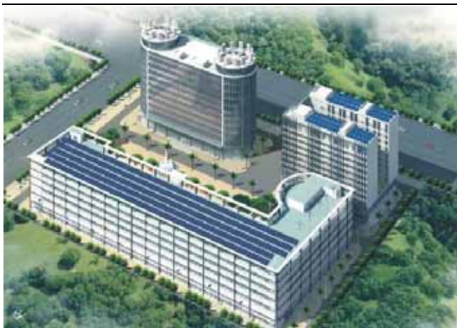
图表 2.拓日产业园建筑一体化光伏系统
