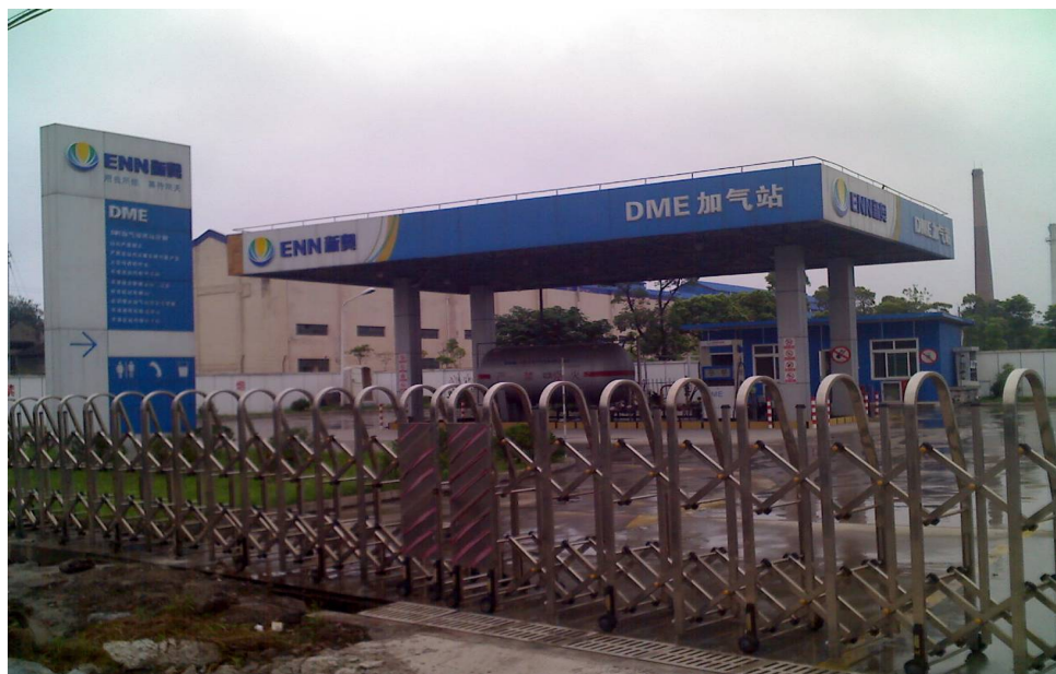
图 14 上海 147 路公交车二甲醚加气站
