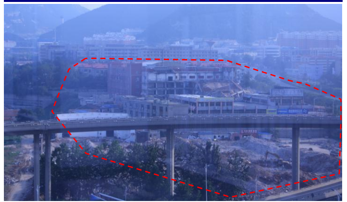
图 10、万嘉隆地块现状图（拆迁中）
