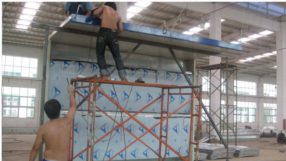
图 20: 梅州项目工人正在进行紧张的喷漆设备安装工作
