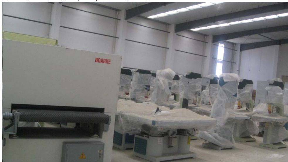
图 9: 木业城二期厂房已建好，设备已到位
