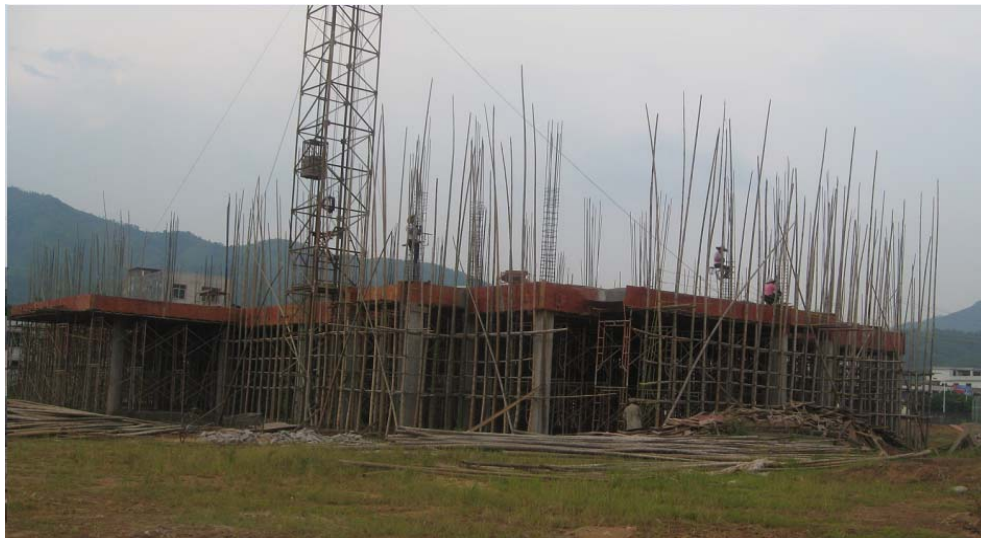
图 24: 梅州项目在建中的行政办公楼
