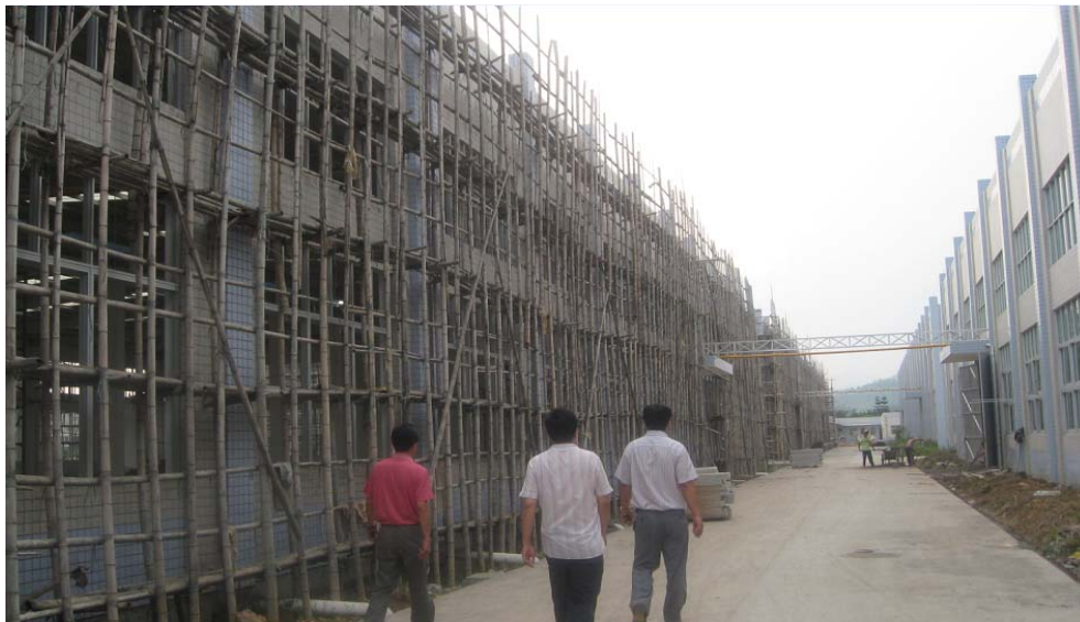
图 22:梅州项目厂区占地面积广阔
