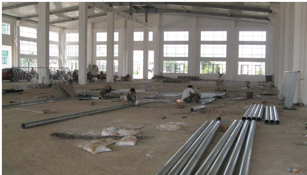
图 13: 濠江项目厂房内正在进行装修和收尾工作
