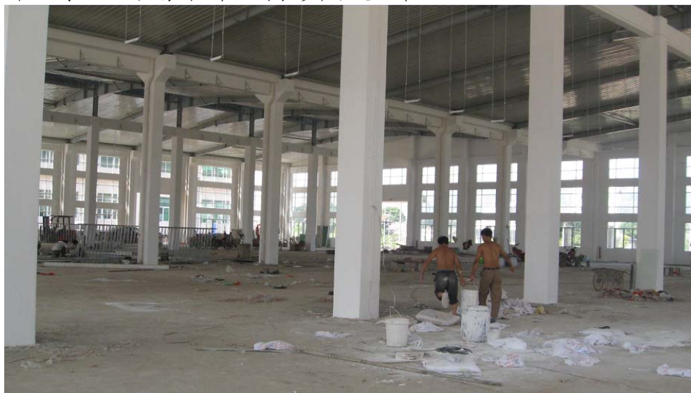
图 12:濠江项目厂房内正在进行装修和收尾工作
