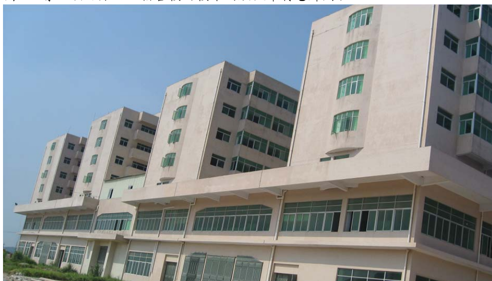
图 14: 濠江项目办公、宿舍楼（楼下两层做中转仓库用）
