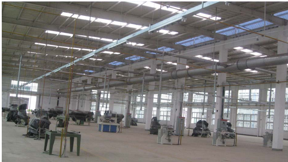
图 19:梅州项目厂房已建好、大部分设备已安装就绪
