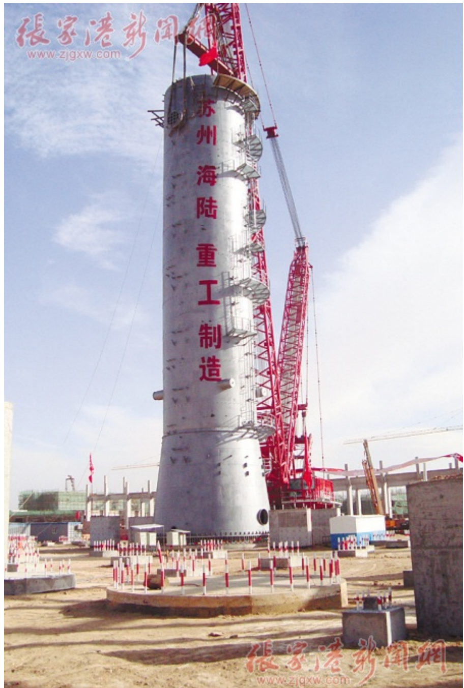
图 4：神华宁煤公司煤制烯烃项目生产的 C3 分离塔
