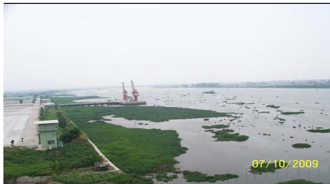
图 6 广东榕泰老厂区现场
