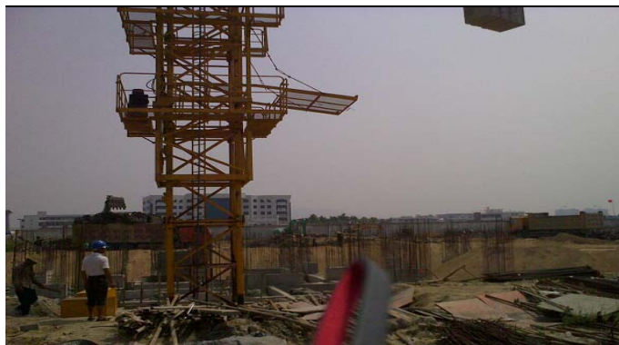
图 4 广东榕泰房地产项目一期现场
