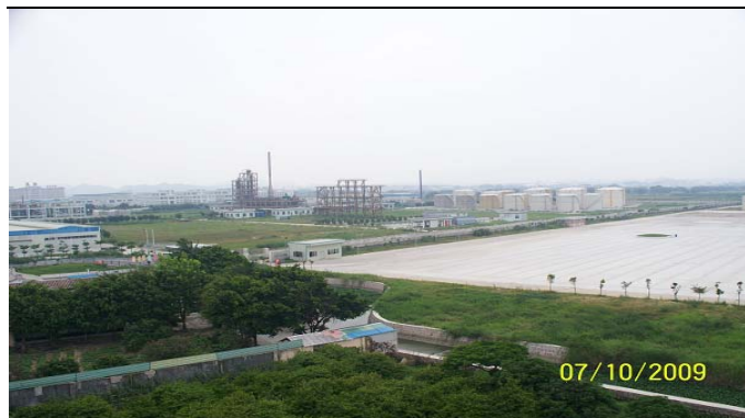
图 5 广东榕泰老厂区现场
