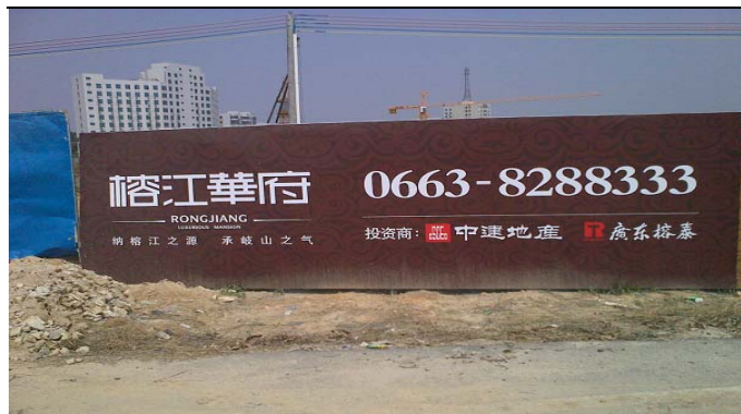
图 3 广东榕泰房地产项目一期现场
