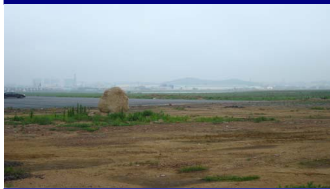
图 3：胜通海岸填海造地项目现场图二
