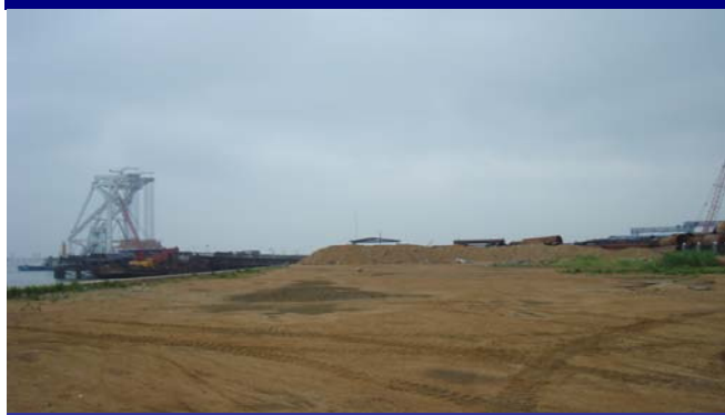
图 2：胜通海岸填海造地项目现场图一
