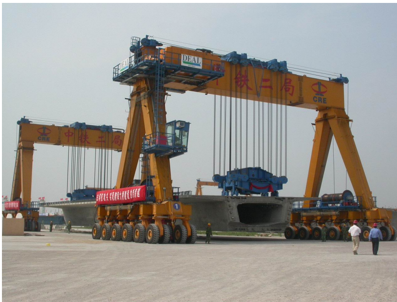
图 26 在杭州湾跨海大桥使用的提梁机
