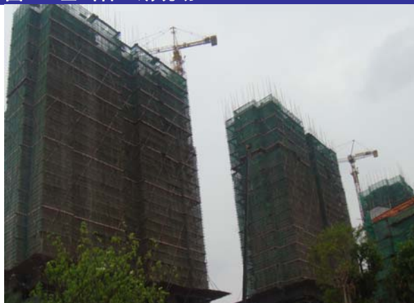
图 7、金山谷二期现场
