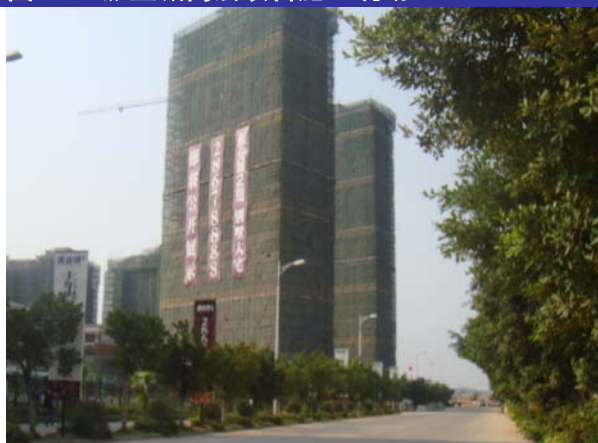
图 12、振业城高层项目施工现场 1
