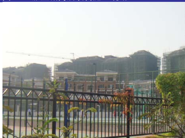
图 13、振业城高层项目施工现场 2
